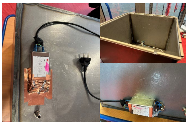
Abbildung 9: Schirmbox zur Reduktion der Störungen des Zusatzequipments. Die 230 Vac Versorgung wird mittels zweistufigem Filter an der Durchführung in die Box gefiltert. Geschirmte Leitungen werden an der Schirmdurchführung an Gehäusemasse angeschlossen, der Deckel wird mittels HF-Dichtungen abgedichtet, um elektromagnetische Abstrahlung über Öffnungen zu verhindern
